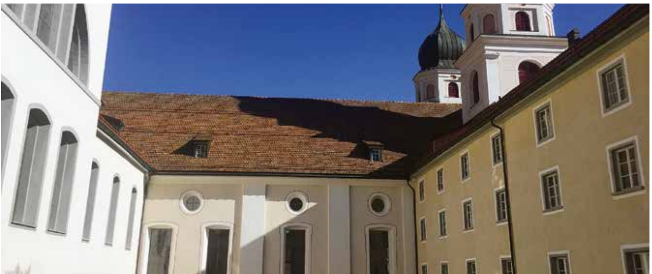
Blick auf neu restaurierte Westfassade und restaurierte Kirchtürme.
