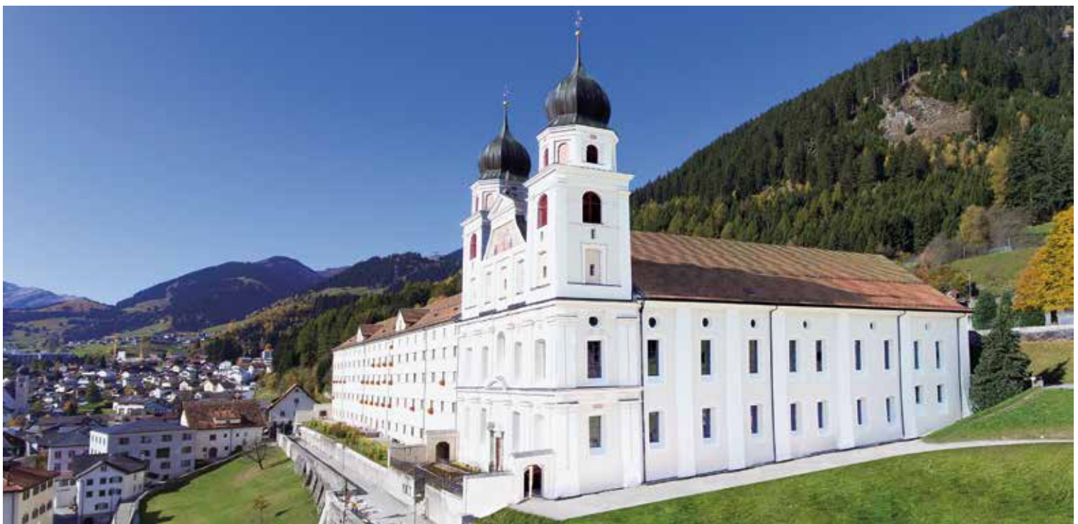
Die Aussenrenovation und Aussenrestaurierung der Klosterkirche St.Martin waren Ende 2017 abgeschlossen.
