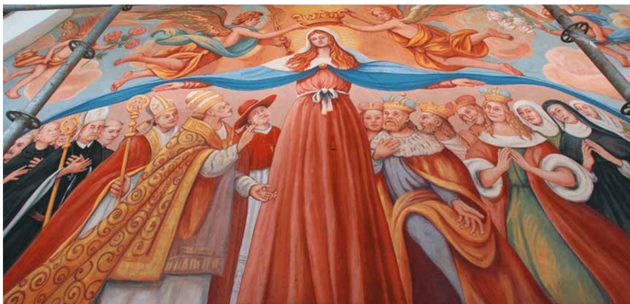
Blick vom Baugerüst auf das frisch restaurierte und rekonstruierte Fresko (2016) der Schutzmantelmadonna an der Südfassade der Klosterkirche St. Martin.
